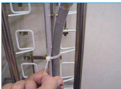
① ケーブルを固定位置で結束バンド等を使用して固定します。
