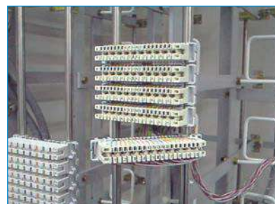
⑨ モジュールの取外し・移動 ● モジュールを下から片手ですくい、指で押し上げながら片側ずつはずします。
