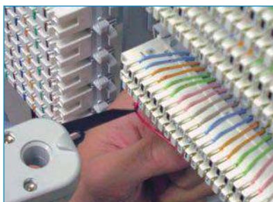
⑧ 芯線の着脱 ● 接続ツールの側面に装着してあるフックを使用し、芯線を手前に引き抜きます。
