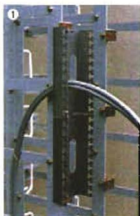
STEP 1 ワイヤーをクリッピング クローブに引き入れる。
