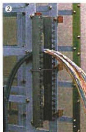
STEP 2 接続工具でワイヤーを 押し入れる。
