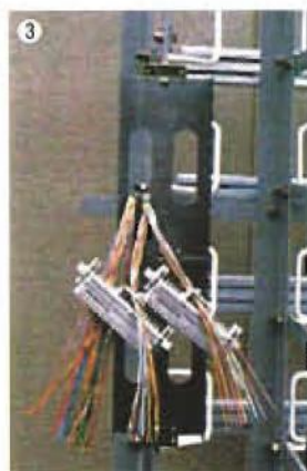
STEP 2 接続工具でワイヤーを 押し入れる。
