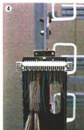
STEP 3 適切に接続されるとともに ワイヤーの余長が切断される。
